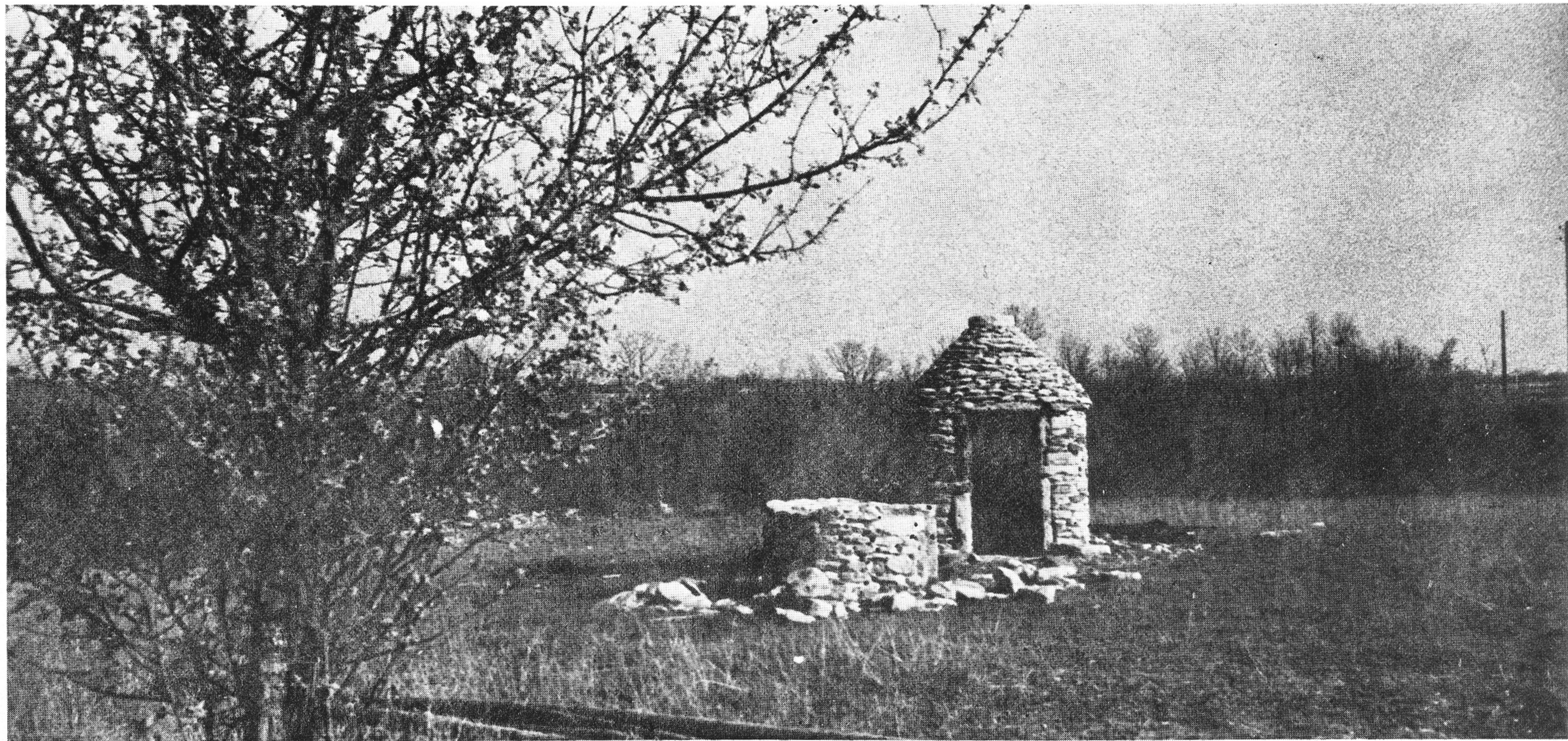
En cours de construction (1966). Cliché Lassure.
